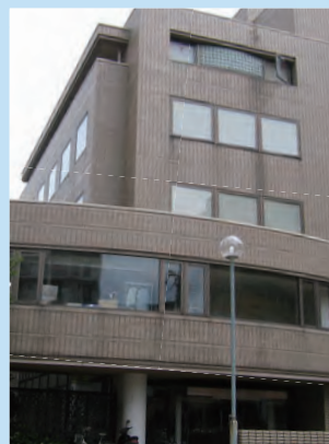
九州支店（福岡市博多区） Kyushu branch office
