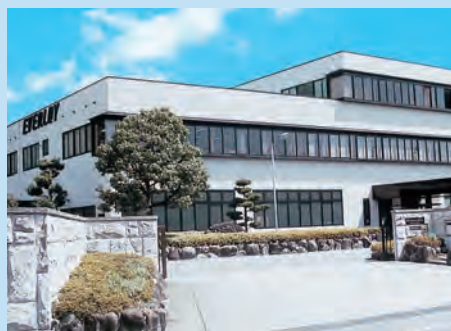
柏原工厂超硬合金事业部合金部（兵庫県丹波市） Kaibara Works Cemented carbide division Alloy department
